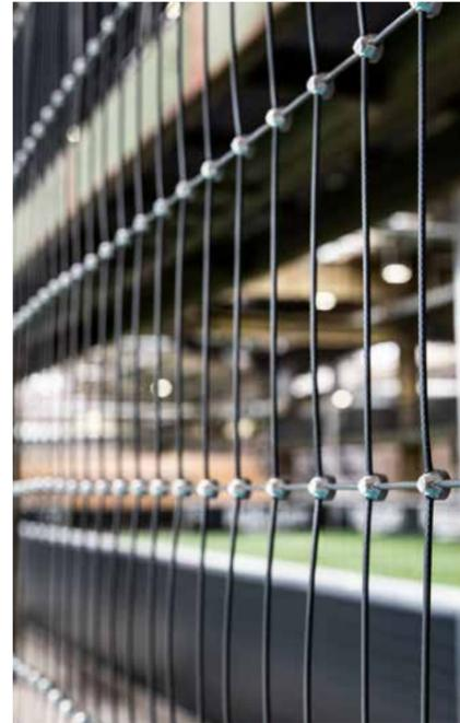
... und mit geräuscharmen Stahlseilnetzen mit Kunststoffummantelung.
